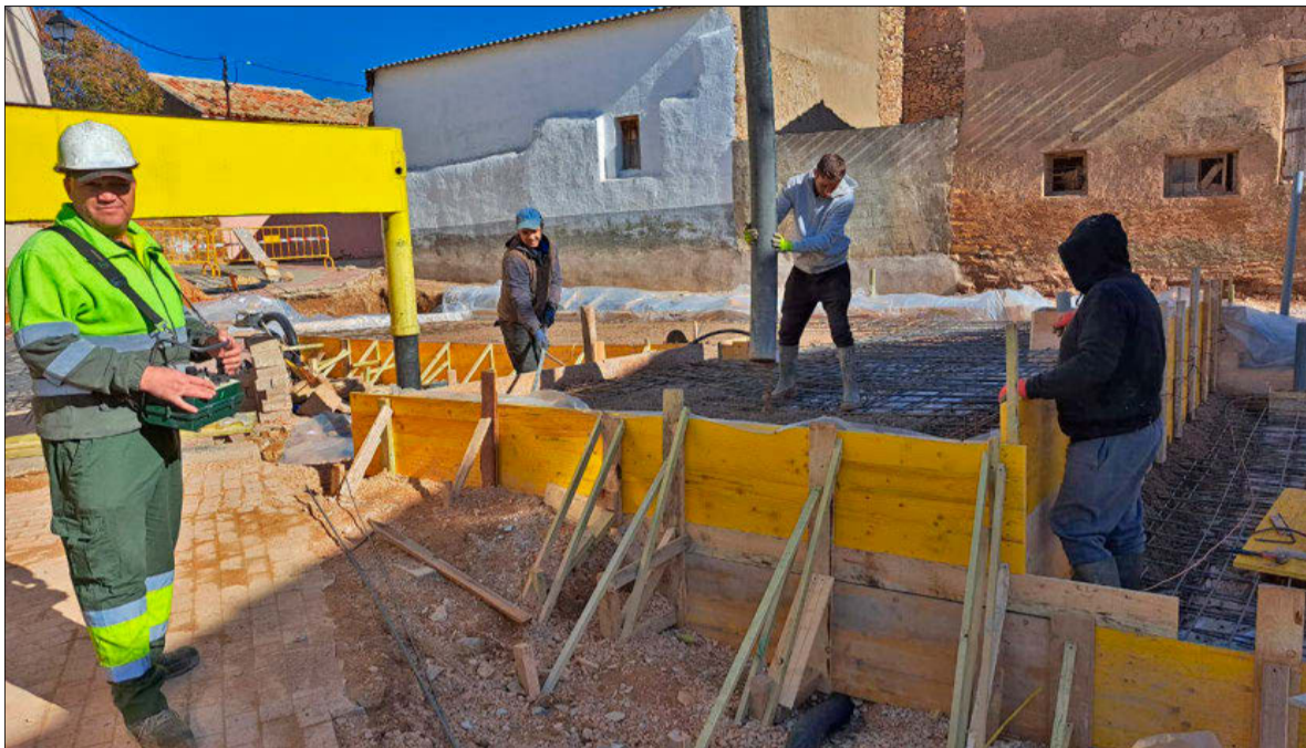
Obras de construcción de las nuevas viviendas destinadas a alquiler a Fuentesestrún. HDS
