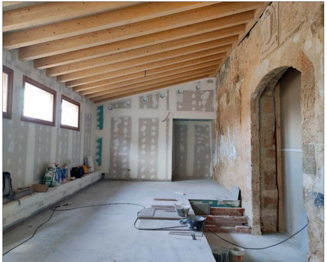
Obras en el centro de recepción de visitantes en la catedral de El Burgo. HDS
